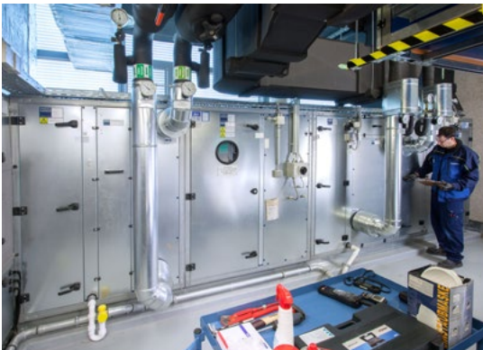
Überprüfung, ob die RTL-Anlage vollständig installiert ist
