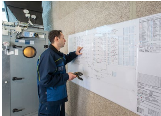
Bestandszeichnung (Revisionsplan) zur Orientierung in einer Lüftungszentrale
